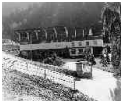
Figura Number range Figura: Centrale Castelpietra
